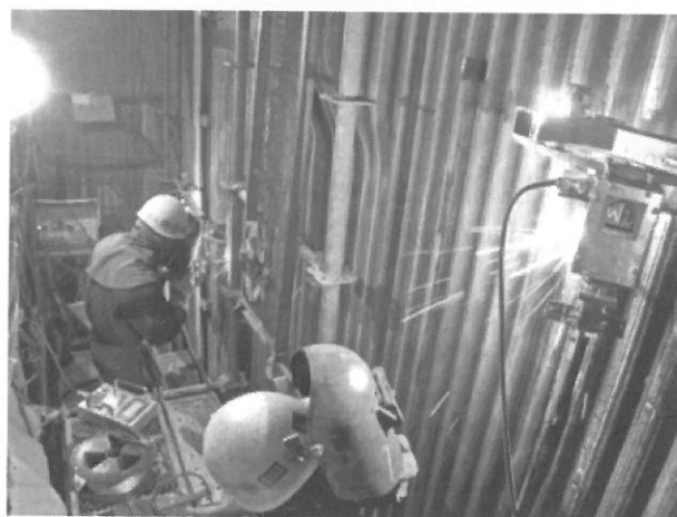
写真4 石炭焚きボイラ火炉水冷壁パネルの現地自動肉盛施工状況
