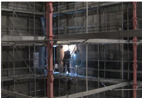
火力発電用ボイラ内の状況
