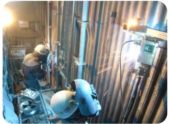
ボイラパネルの現地施工例
