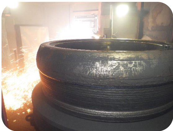
ローラ自動ガウジング施工
